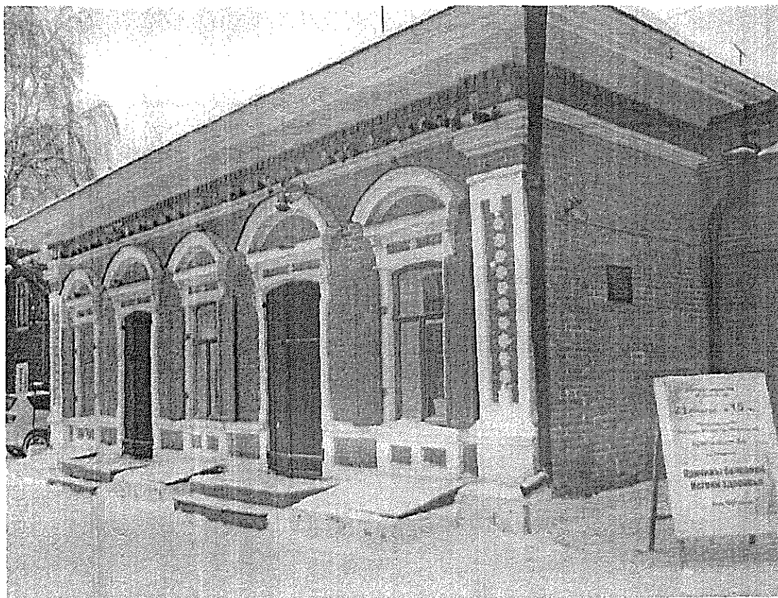
Фото 1. Вид с юго-восточной стороны
